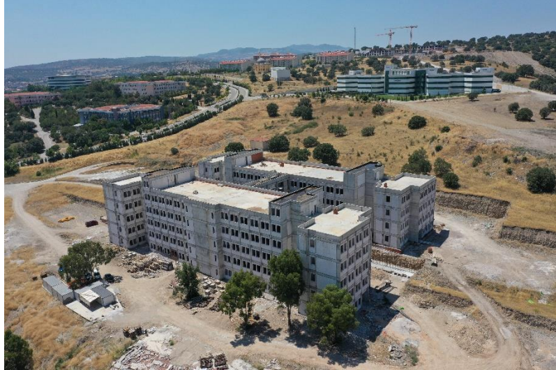
Derslik ve Merkezi Birimler İnşaatı
